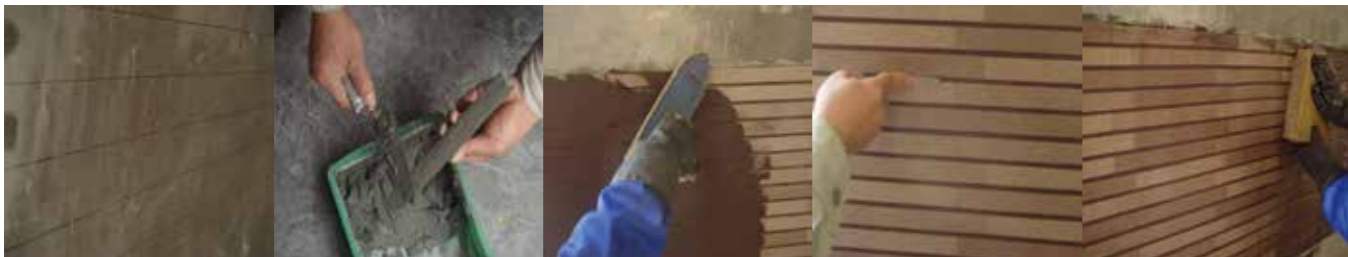
墙面、基层处理
